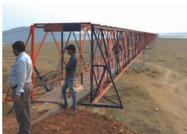
飲料水の取水ダムに至る橋の建設
