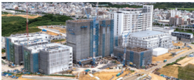
工事中の新しい西普天間キャンパス(医学部・病院) (2024年6月)
